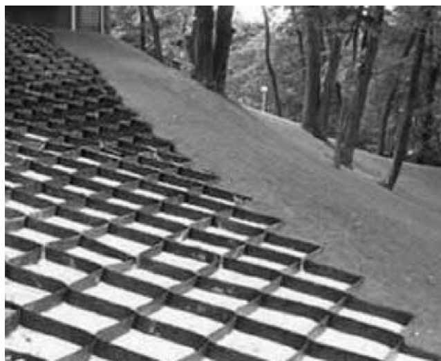
Рис. 4. Приклад встановлення георешітки
