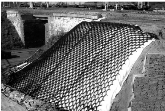
Рис. 1. Приклад влаштування геотекстилю на схилі
