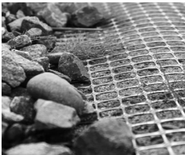
Рис. 3. Приклад встановлення геосітки
